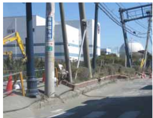
図 1.9 液状化による地盤沈下
